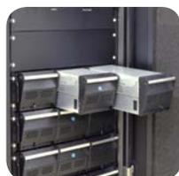
Для ИБП данной серии предлагаются батарейные модули для установки внутри ИБП и внешние батарейные кабинеты
