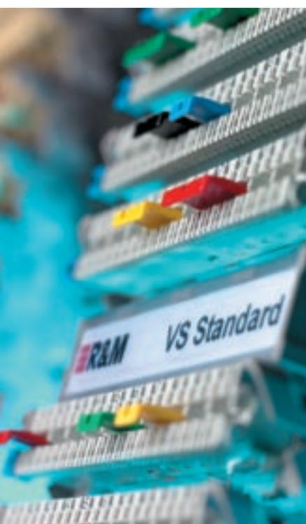
Первичная защита с тыльной стороны означает простоту обслуживания: коммуникация и тестирование производятся с лицевой стороны, что обеспечивает постоянную защиту персонала. Тыльный магазин защиты может находиться в подключенном состоянии в процессе наращивания емкости. Конструкция обеспечивает достаточно пространства и аксессуаров для укладки кабеля, разгрузки от растягивающих усилий, поворотов, обвязки, что упрощает наращивание емкости в дальнейшем.
