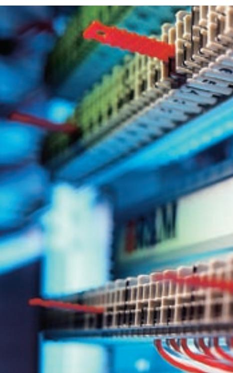
Благодаря очень компактному дизайну, семейство модулей характеризуется оптимальным использованием пространства. Достигнута плотность монтажа до 4200 пар/м<sup>2</sup>.
