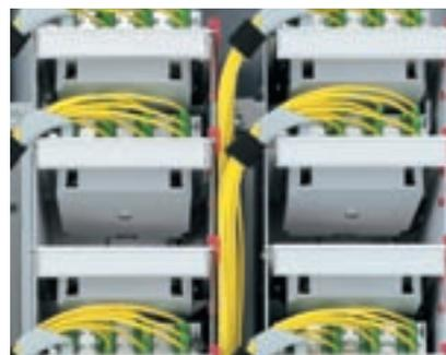
FiberCurb II гарантирует механическую защиту патчкордов, обеспечивая минимальный радиус изгиба 40 мм.
