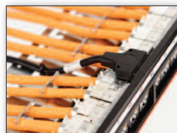
Вилка шнура ввода/вывода, подключенная к разъему на коммутационной панели LANsense
